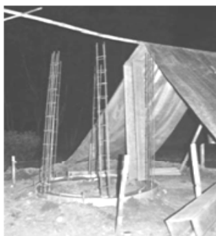
Gambar 9. Pembuatan fondasi dan kontruksi pustek patung di bundaran Kampus 2 Mojosongo FSRD ISI Surakarta, Foto Amir Gozali 2016.
