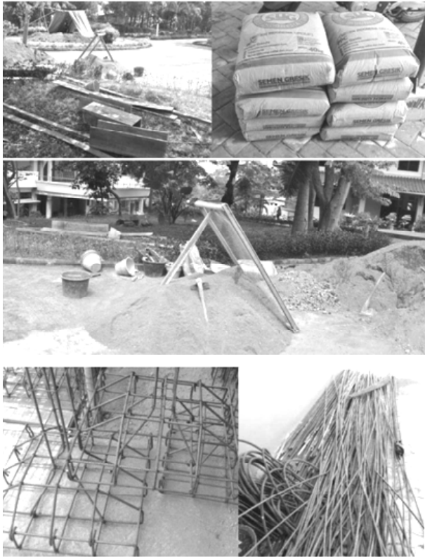
Gambar 4. Kayu papan, semen, pasir, besi beton untuk bahn pembuatan patung, Foto Amir Gozali 2016.
