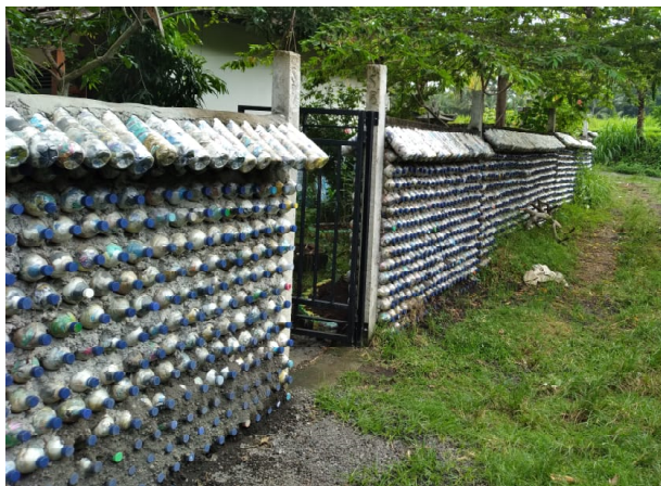
Gambar 7. Tembok pekarangan TBK dan SSJB dari ecobrick.
