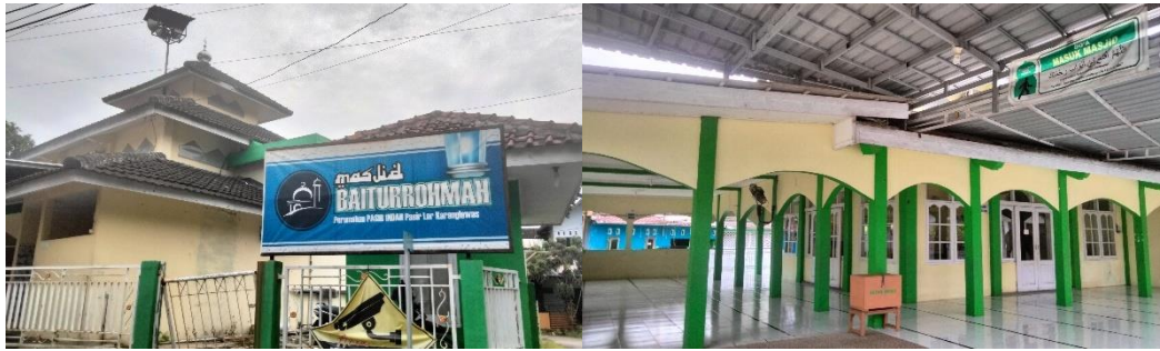
Gambar 3. Kondisi Eksisting Arsitektur di Area Masjid Baiturromah Perumahan
