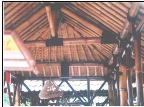
Gambar 16. Interior **Warung Makan Lesehan Rasa Mirasa** pemanfaatan anyaman bambu (gedeg) sebagai plafon (ceiling) yang paling sederhana dipasang di sebelah atas usuk (kasau). Sistem konstruksi
