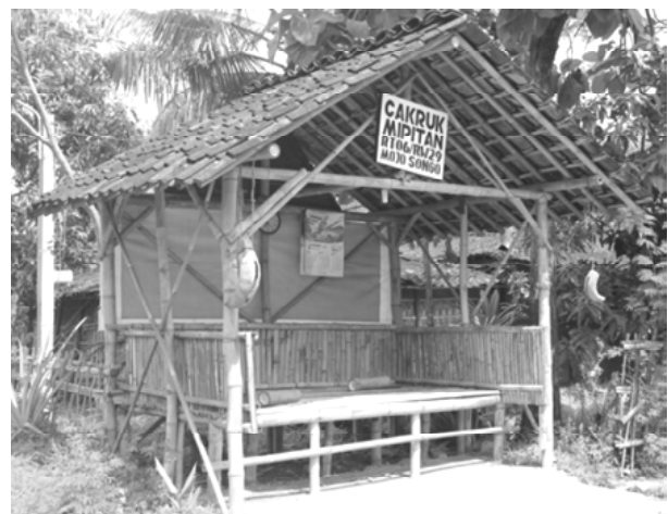
Gambar 1. Gardu pos ronda di Mojosongo RW 29 dengan struktur lantainya kolong.
