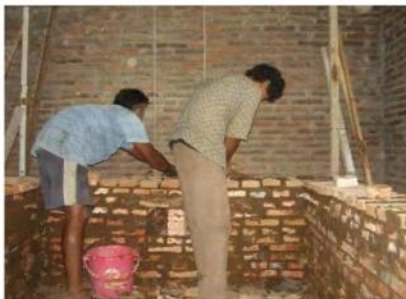
Gb.07 Proses pembangunan dinding tungku
