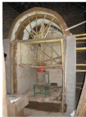
Gb.08 Proses pengeringan selama dua minggu (kiri) dan proses pelapisan ceramic fiber .
