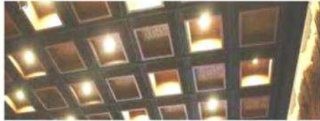
material matresin sebagai bahan penyerap bunyi yang didesain sebagai elemen pendamping ceiling, sehingga terintegrasi secara desain dan fungsi.
