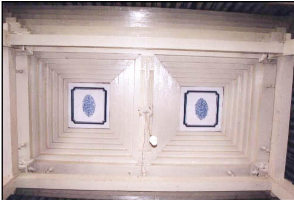
**Foto 3.** Konstruksi atap *Brunjung* yang tersusun dari beberapa jenis balok, misalnya: *balok sunduk tengah*, *balok takir*, *balok tumpangsari*, *balok tumpang*, *balok penanggap*, dan *balok tutup kepuh*.
