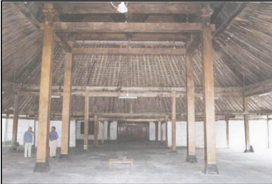
**Foto 10.** Empat buah *soko guru* sebagai penyangga utama dan bagian-bagian konstruksi atap lainnya belum difinishing dengan baik untuk menjaga keawetannya.
