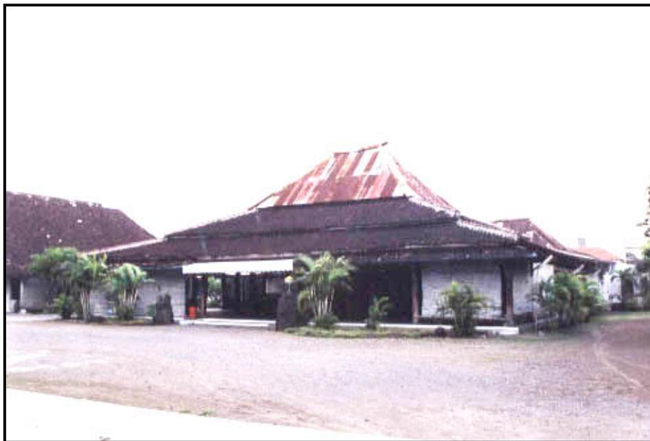
**Foto 9.** Atap bangunan Purwodiningratan pada bagian *brunjung* ditutup seng guna menghindari kebocoran.
