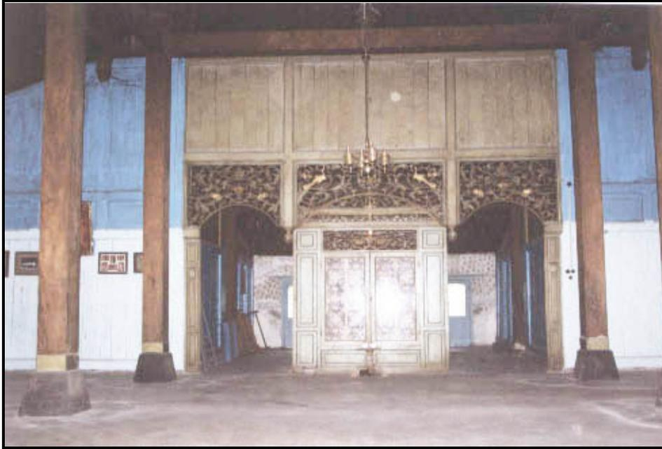
**Foto 14.** Dinding ruang *dalem* sebagian dilapisi dengan cat kayu, namun beberapa pilar tetap dibiarkan tanpa *finishing* karena alasan tertentu.
