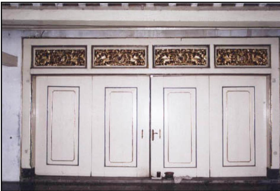
**Foto 5.** Pintu utama antara *Pringgitan* dengan *Dalem* dihiasi ukiran krawang dengan *finishing* prada.
