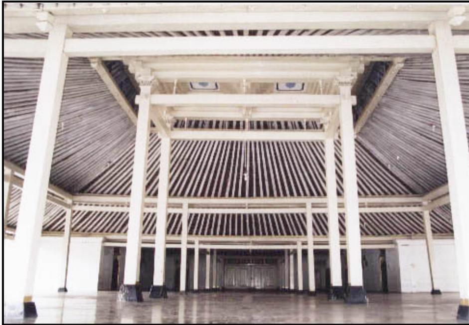
**Foto 2.** Ruang *Pendapa* terdapat *soko guru*, *soko penanggap*, dan *soko emper* sebagai bagian konstruksi penyangga atap. Pada langit-langit (*ceiling*) terlihat deretan usuk yang tersusun secara memusat. Lantai *pendapa* sampai ke *pringgitan* menggunakan tegel.
