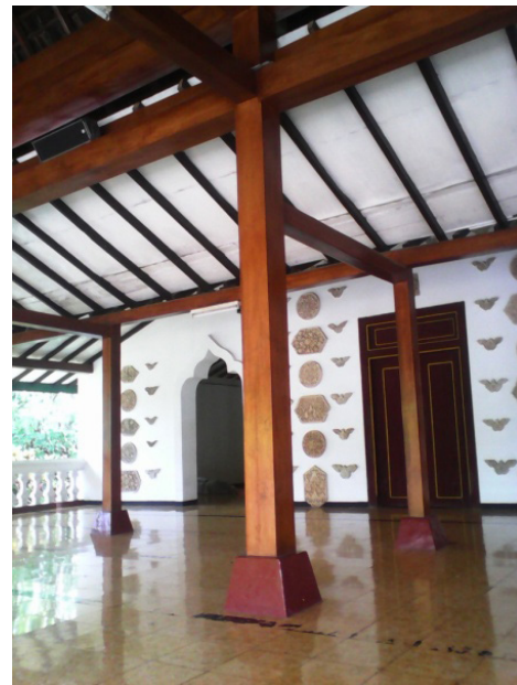
Gambar 6. Struktur fungsi atap, dinding dan lantai (Sumber foto : Eko 2017)
