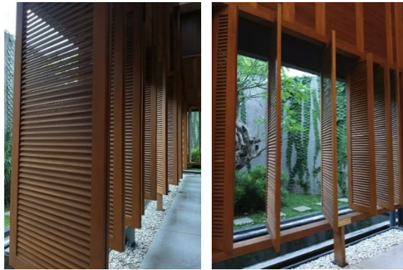
Gambar 5. Detail Jendela Krepyak Kayu Jati dengan Engsel Putar (Mumpuni, 2024)
